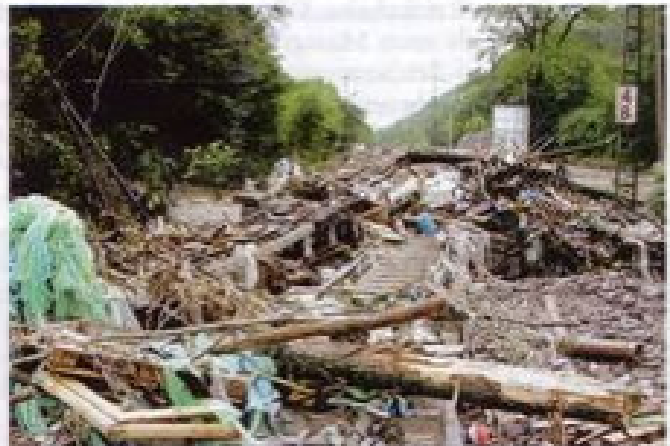
Bild 4: ABS Dresden–Chemnitz–(Nürnberg) zwischen Dresden-Altstadt und Klingenberg-Colmnitz.
